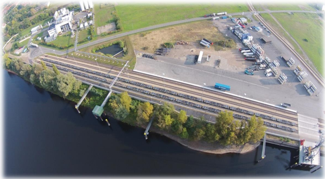
Abbildung 5: Hafenbereich Industrie- und Hafenbahn im Industriegebiet Süd Wittenberge
